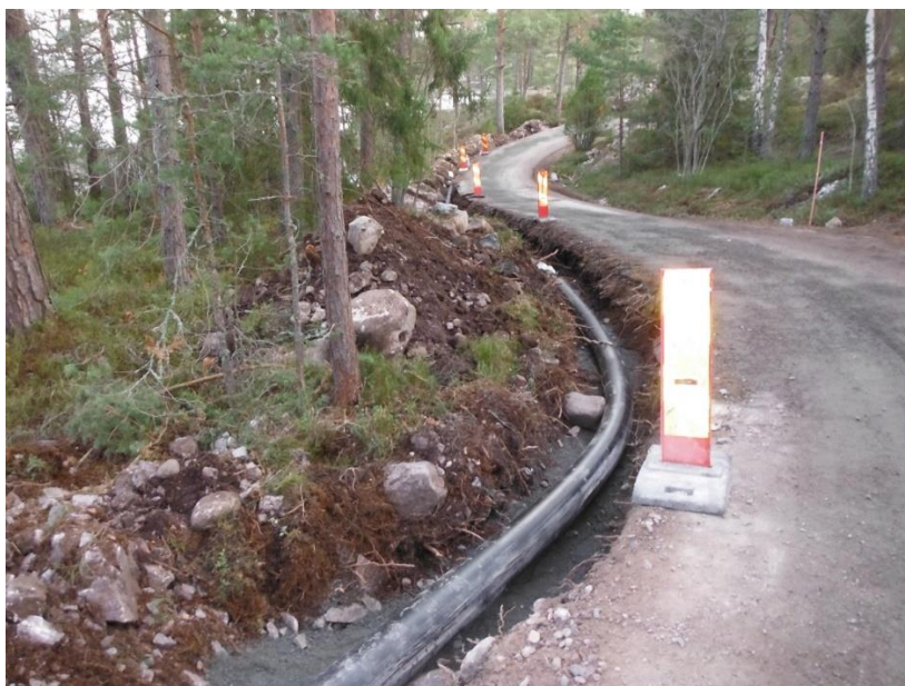
På bilderna ser man att i bergig terräng ändrade AMA teknik och schaktade ned ca en halvmeter lade ned ett isolerat rör med både VoA, fiber, signalledningar samt värmekabel. På ett smidigt sätt ser man hur ledningen kan följa vägen bilderna är tagna på Grönö 2017-01-17 foto I Lindin
