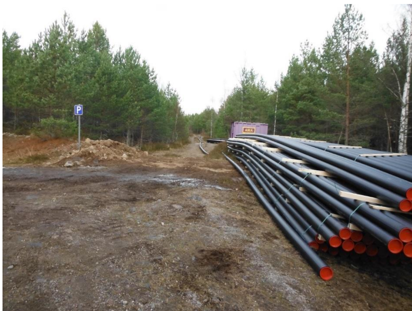
Svetsstation Linneastigen för att få ihop alla rör 2016-01-16 Foto I. Lindin
