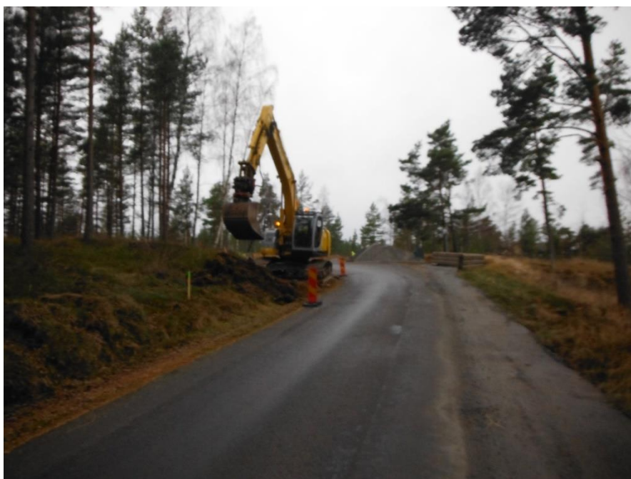
Grävningensarbeten börjar på Pepparängsvägen15-11-24. Foto I.Lindin
