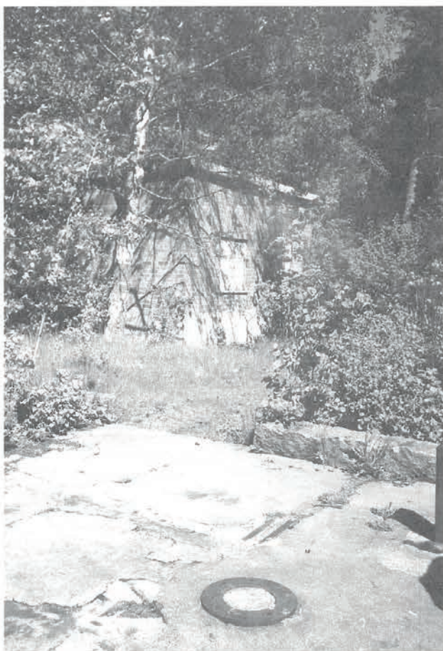
Gamla och nya pumpstationen
