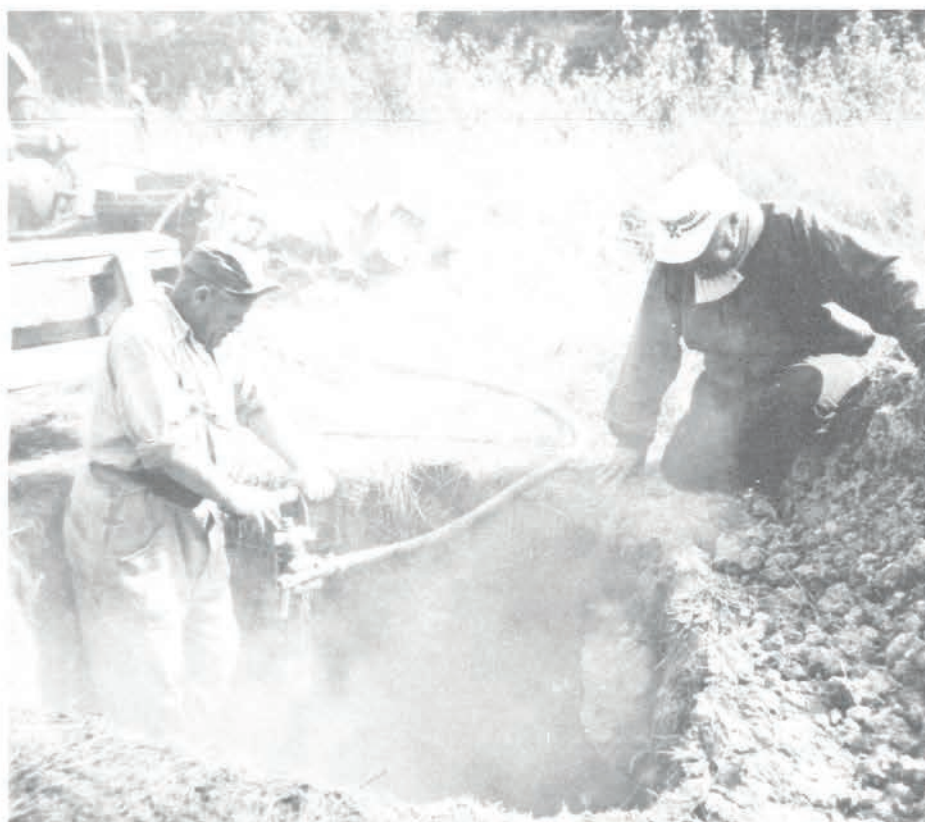
Brunnsgrävning på Grönö, till höger Oskar Dahlberg
